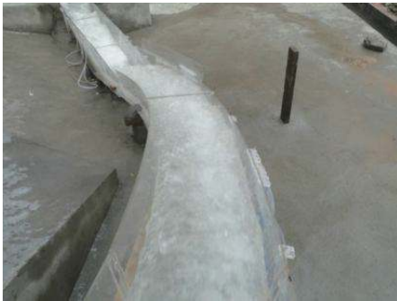
(b) 曲线型阶梯溢洪道+前置掺气坎
